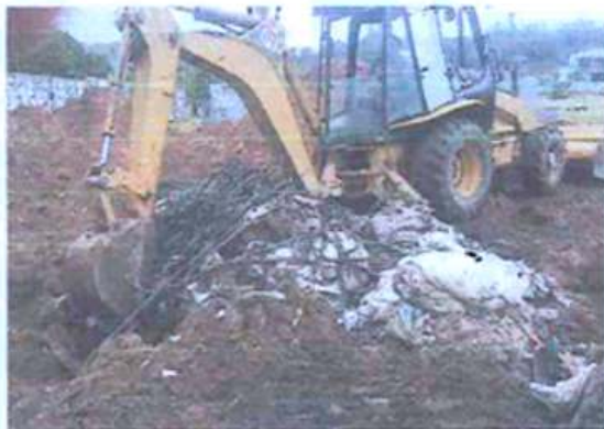
Foto 09: Retroscavadeira retirando material escondido.
